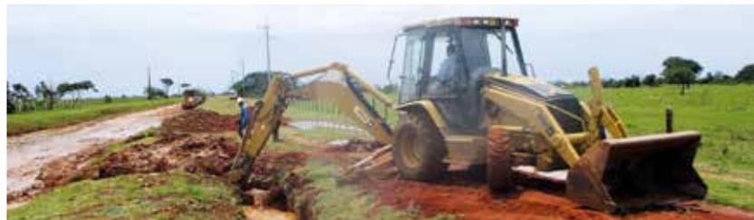
10. Conformación de canales en el carreteable a Puente Arimena.
