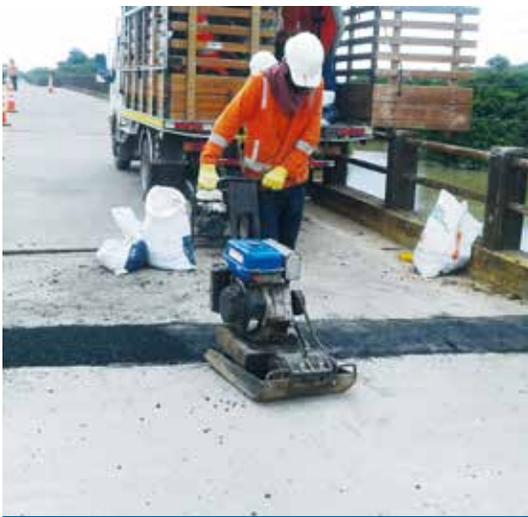
21. Reparación puntual de pavimento en el puente Bajo Menegua.
