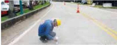
8. Sello de fisuras en las losas de concreto de Puerto Gaitán.
