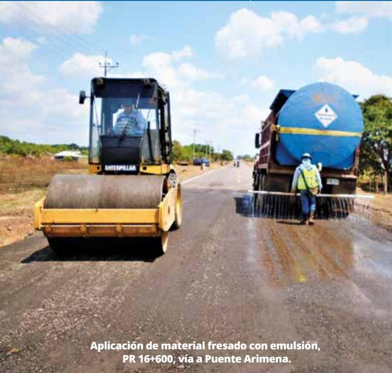
Aplicación de material fresado con emulsión, PR 16+600, vía a Puente Arimena.
