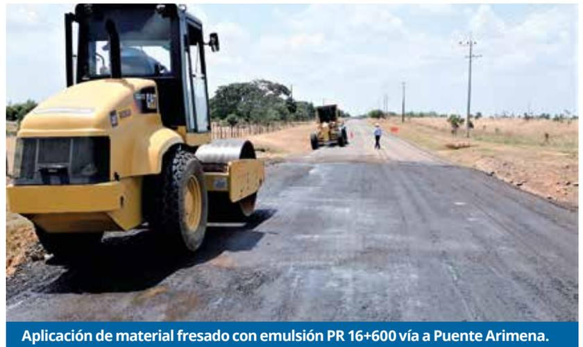
**Aplicación de material fresado con emulsión PR 16+600 vía a Puente Arimena.**
