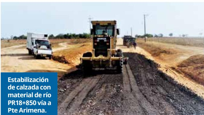
**Estabilización de calzada con material de río PR18+850 vía a Pte Arimena.**
