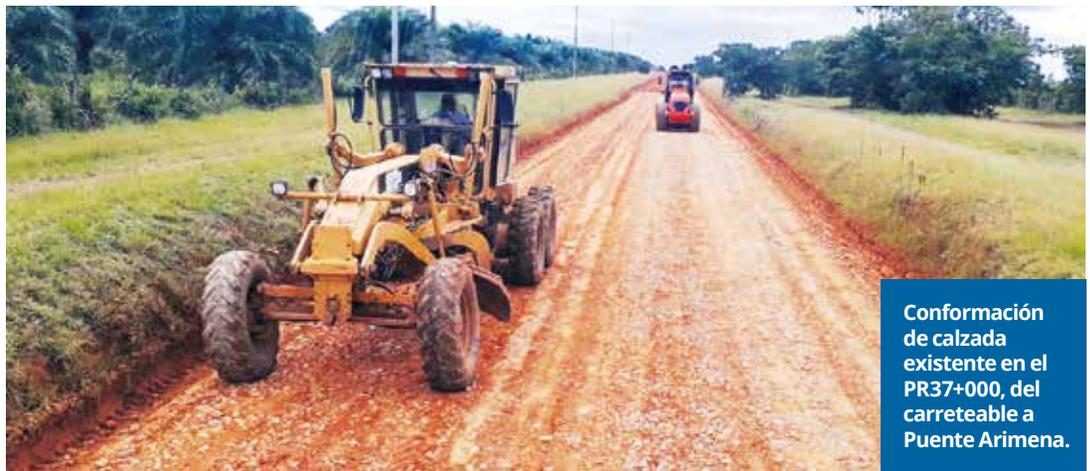
**Conformación de calzada existente en el PR37+000, del carreteable a Puente Arimena.**
