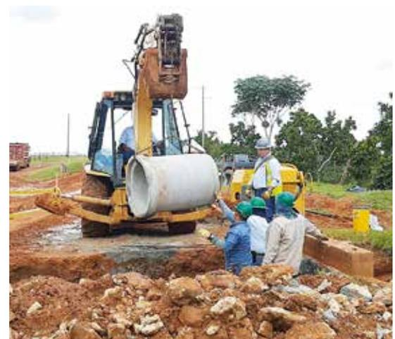
**Construcción de alcantarilla en el PR45+293, vía a Puente Arimena.**
