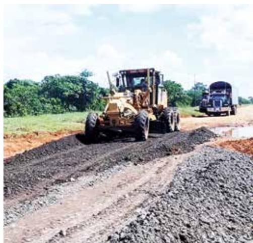
**Extensión y compactación de material de río en el PR49+000, vía a Puente Arimena.**
