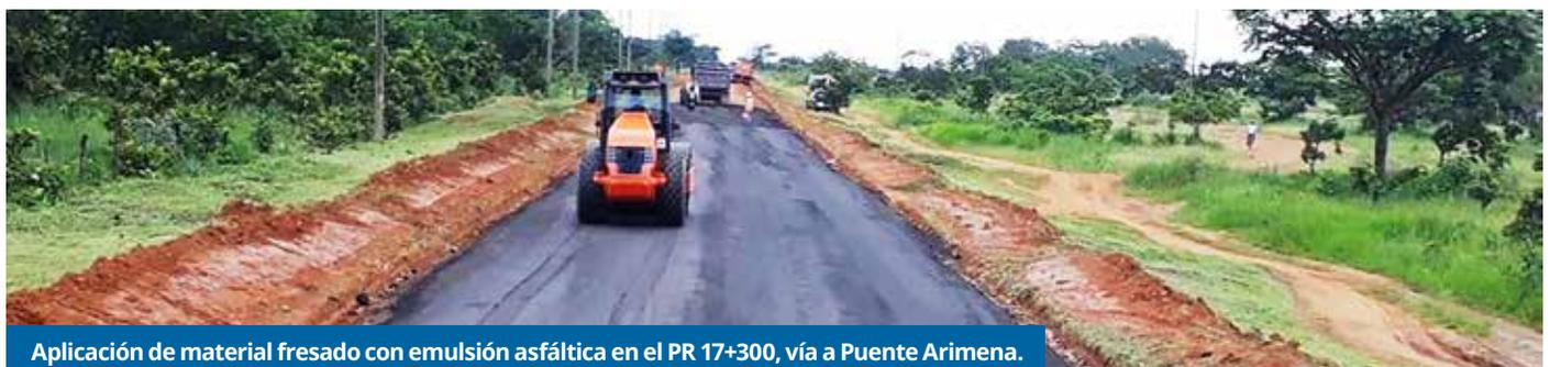
**Aplicación de material fresado con emulsión asfáltica en el PR 17+300, vía a Puente Arimena.**
