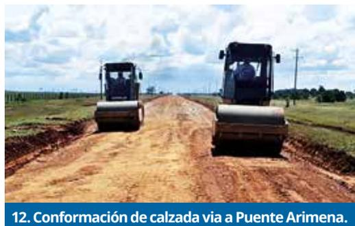
12. Conformación de calzada vía a Puente Arimena.
