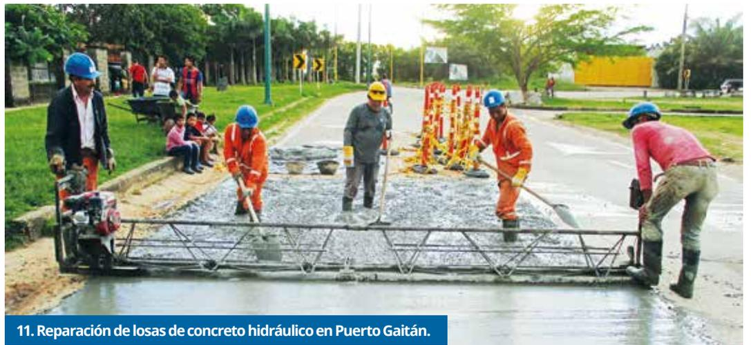
11. Reparación de losas de concreto hidráulico en Puerto Gaitán.
