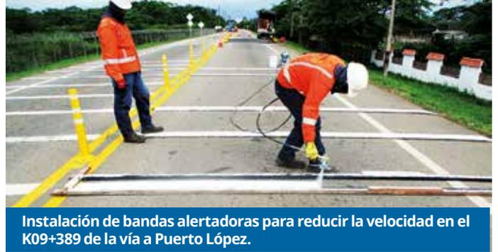
Instalación de bandas alertadoras para reducir la velocidad en el K09+389 de la vía a Puerto López.
