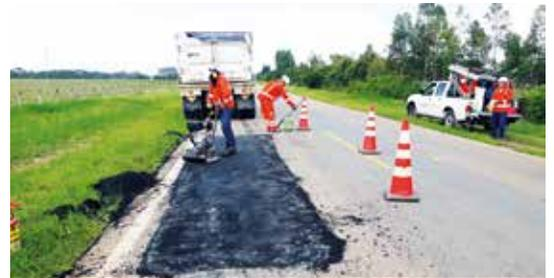
Reparación puntual de pavimento en el PR34+130, de la vía a Puerto Gaitán.
