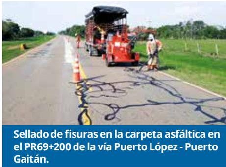
Sellado de fisuras en la carpeta asfáltica en el PR69+200 de la vía Puerto López - Puerto Gaitán.
