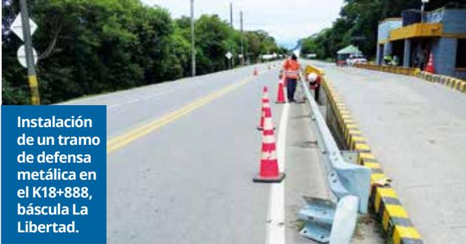
Instalación de un tramo de defensa metálica en el K18+888, báscula La Libertad.
