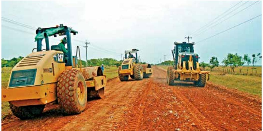
En la vía Puerto Gaitán - Puente Arimena se trabaja en la conformación de la calzada en un tramo de 36 kilómetros.
