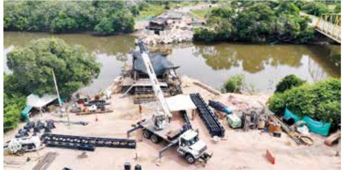
En este trimestre se ha avanzado en la construcción de la cimentación del nuevo puente sobre el río Yucao, en la vía a Puerto Gaitán.
